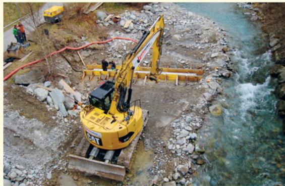
Au printemps 2015, une nouvelle station de mesures du charriage a été construite dans l'Albula près de Tiefencastel (GR).
