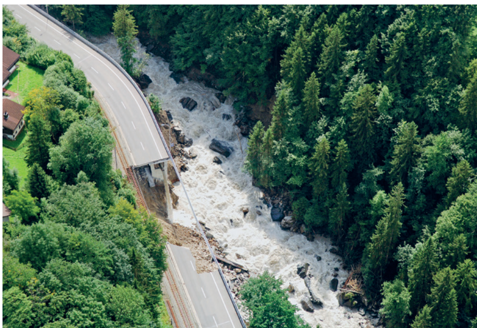
Die Engelberger Aa untergräbt während des Augusthochwassers 2005 die Zufahrtsstrasse unterhalb von Engelberg.
