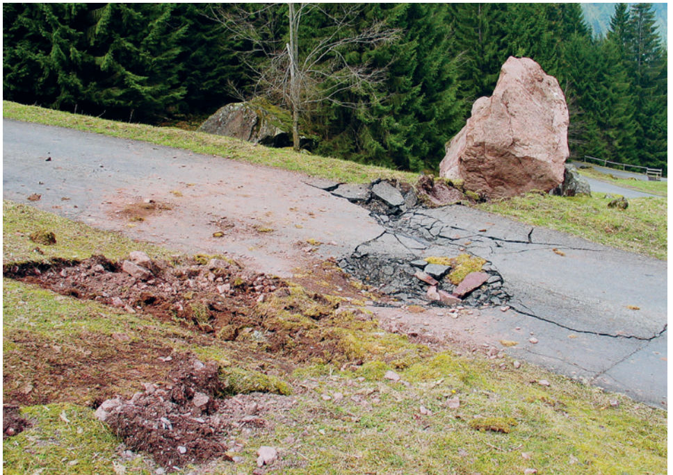
Murgtal, April 2005. Ein Felsblock donnert den Berghang hinunter und prallt auf die Murgtalstrasse. Das Entwicklerteam des Software-Pakets RAMMS nutzte dieses Ereignis, um das neue Steinschlag-Modul zu testen.
