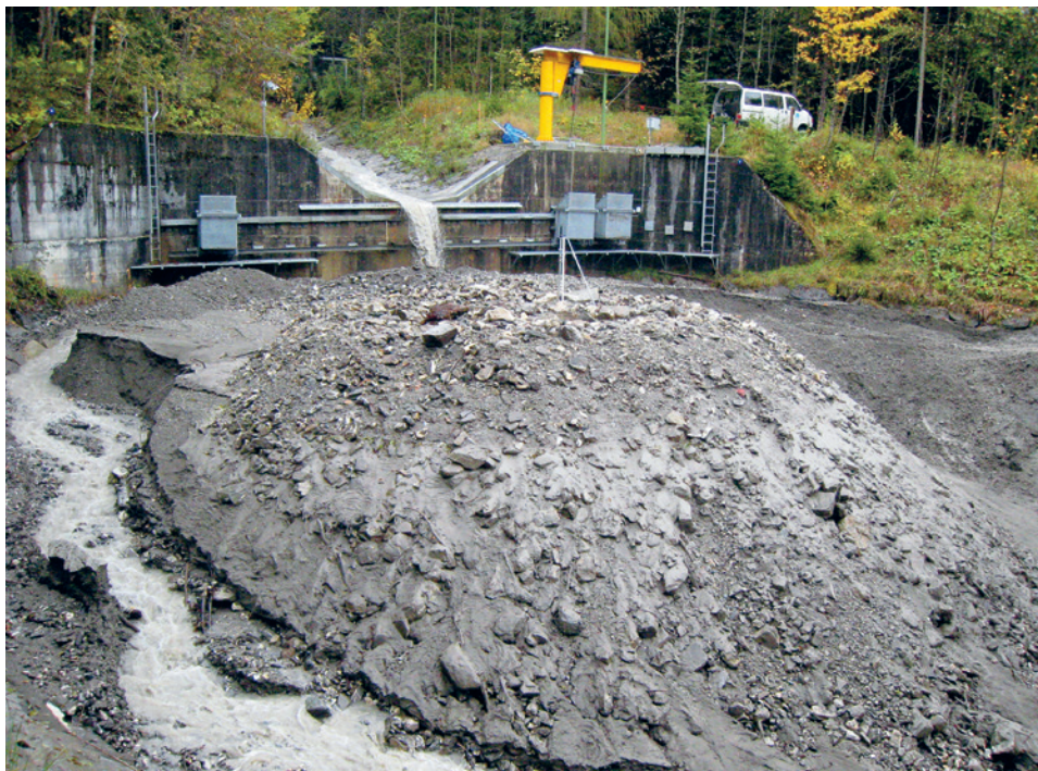
Das Geschiebe, das der Erlenbach bei Hochwasser transportiert, sammelt sich im Rückhaltebecken an. Das Material wird regelmässig vermessen und danach ausgebaggert.
