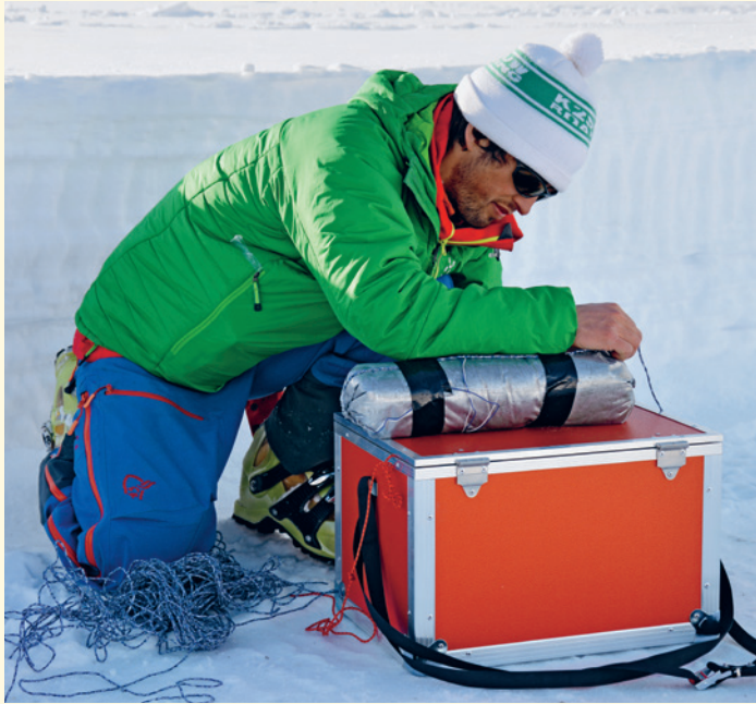
Stephan Simioni bereitet eine Sprengladung in Hinterrhein vor.
